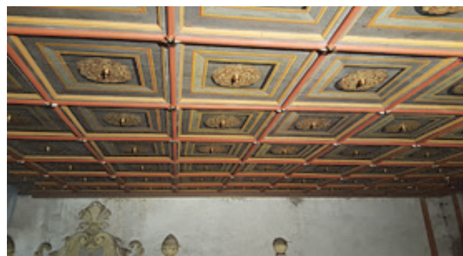
Ukázka části osazeného stropu v lodi kostela
