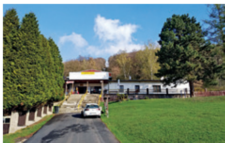
Dolní stanice, rok 2022
