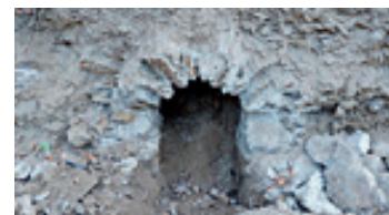
Pravděpodobně odtoková šachta z hradebního jádra
